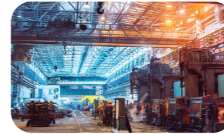
철강 퍼니스 장비 최적 온도 제어: LNG 사용 2% 효율화
